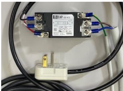
ノイズフィルター結線例
